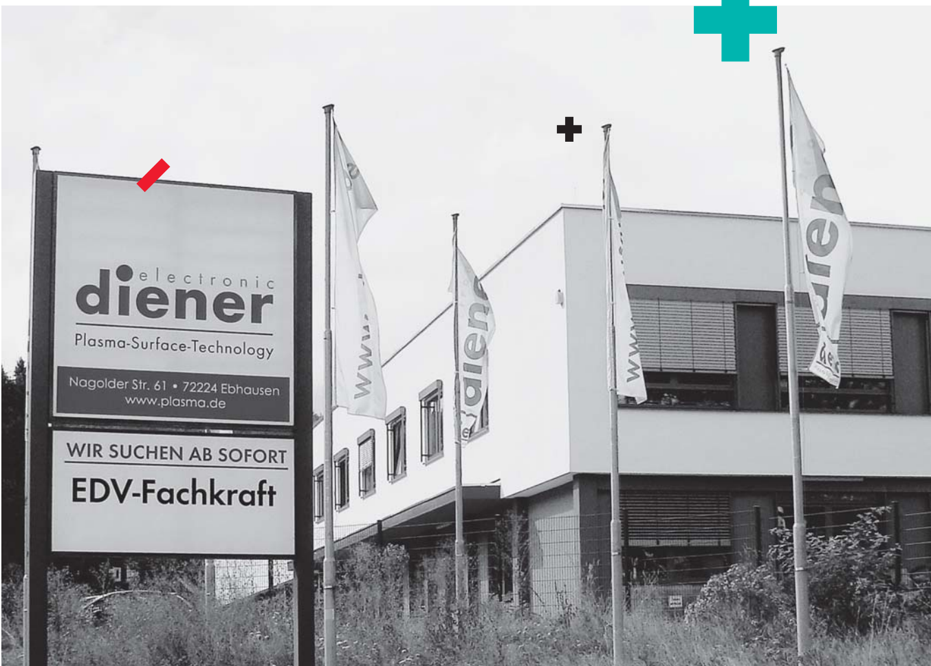
Здание штаб-квартиры Diener Electronic
