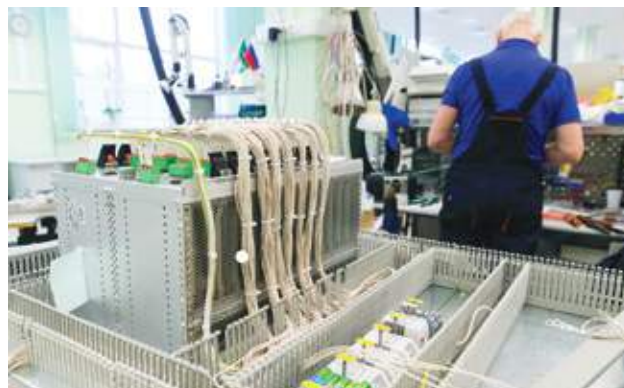
Выполнение электромонтажных работ (ООО «Прософт-Системы»)
