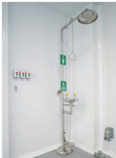
Рис. 17. Аварийный душ на участке химической обработки
