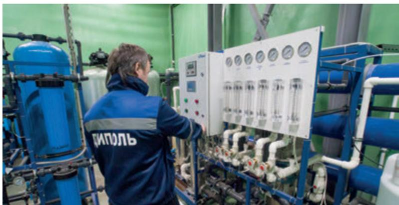
Рис. 15. Установка деионизации воды
