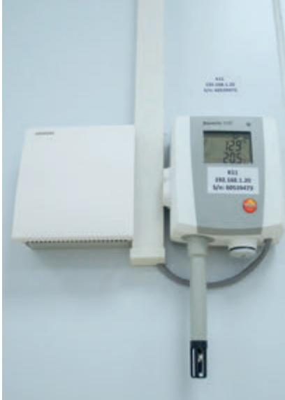
Рис. 8. Датчики микроклимата и влажности
