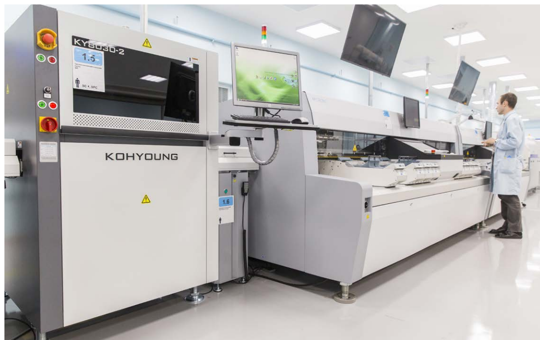
Производственные помещения, оборудованные компанией «Диполь» на предприятиях заказчиков
